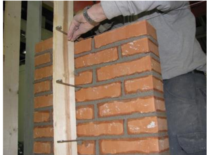
Foto 4. I den resterende del af væggen højde indsættes 1 binder pr 3. skifte. 1 binder gældende for en vægbredde op til 0,96 m eller 4 sten. Ellers 1 binder pr 0,96 m/4 sten
