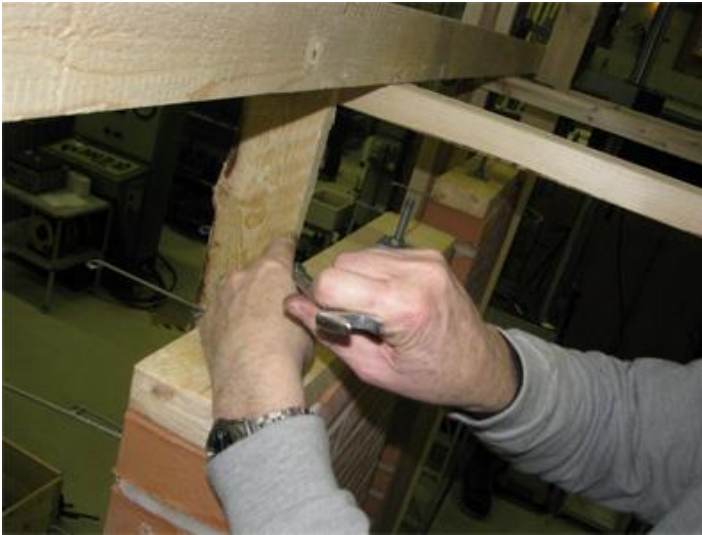
Foto 7. Rem monteres med spændeskive og møtrik
