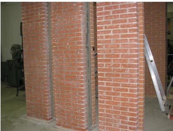
Foto 20. Bemærk formuren kan være længere tid om at hærde og tørre ud end normalt, da dette kun kan foregå fra 1 side mod normalt 2 (væg til højre er uden EPS).
