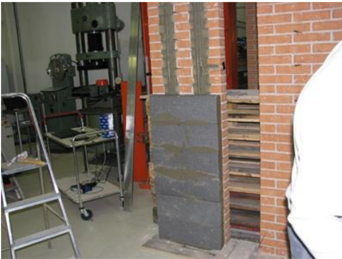
Foto 9. EPS-blokkene påsmøres lim i liggefuge og på bagside og trykkes mod bagvæg (vådt i vådt). Der anvendes tandspartel eller andet egnet værktøj.
