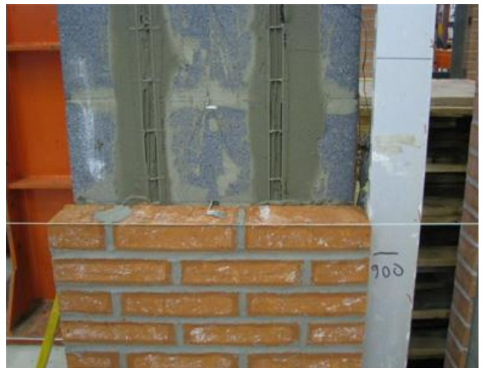
Foto 12. På EPS påføres Multiklæb i baner som armeringen presses ind i.
