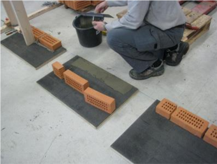
Foto 1. Opmuring af bagmur startes på sædvanlig vis. Eventuelt vælges en lim-pap-lim løsning i bund for at forøge forskydningskapaciteten mod sokkel
