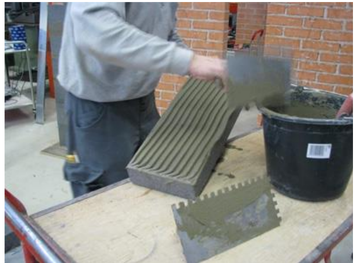
Foto 10. Påsmøring af Multiklæb
